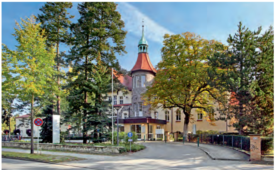
DIfE Potsdam-Rehbrücke, Quelle: Till Budde/ZAB GmbH durch EFRE gefördert.
